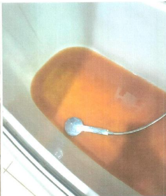
Фотоиллюстрация 18. Загрязненная горячая вода в квартире № 202 после ремонта трубопроводной системы ГВС 21.12.2021
